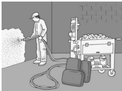
Fig 24. Proyección en paramentos verticales
