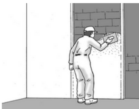
Fig 19. Tendido del yeso entre miras
