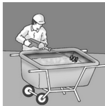
Figs. 4, 5 y 6. Vertido del yeso sobre el agua y amasado mecánico.
