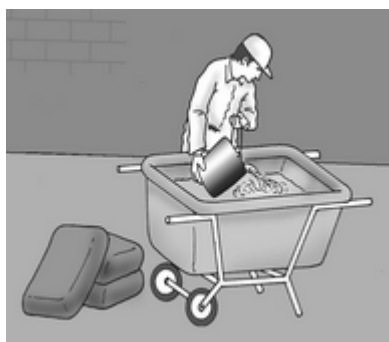
Figs. 4, 5 y 6. Vertido del yeso sobre el agua y amasado mecánico.
