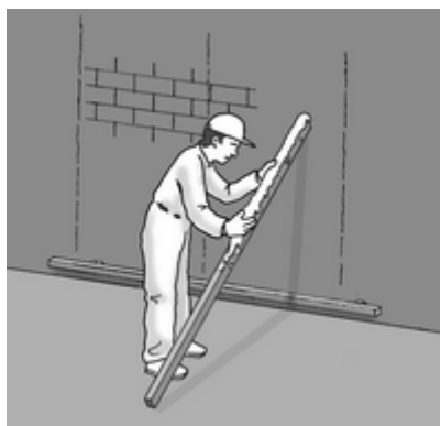
Figs. 16 y 17. Se aplica la pasta de yeso sobre las miras y se reciben las miras sobre la pared. Se aprietan las miras y se comprueba la verticalidad de las mismas con el nivel de burbuja
