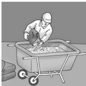
Figs. 4, 5 y 6. Vertido del yeso sobre el agua y amasado mecánico.
